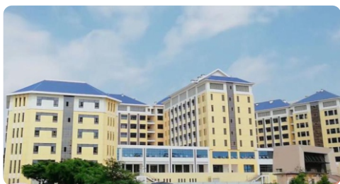
实训综合大楼
